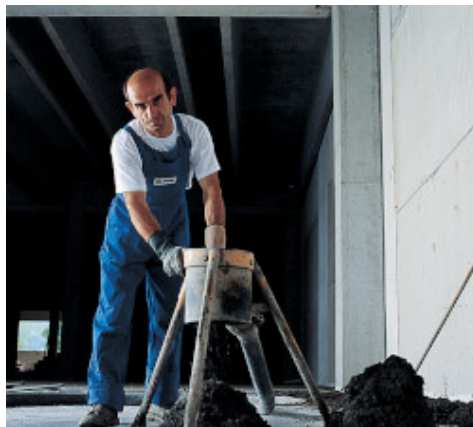
Batching a Mapecem mix
